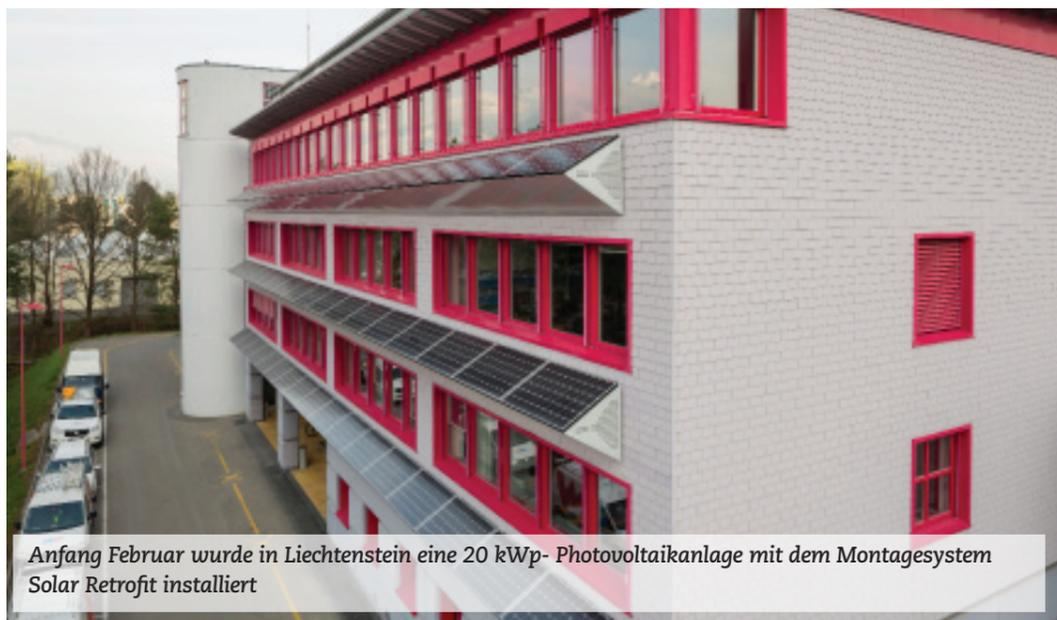
Anfang Februar wurde in Liechtenstein eine 20 kWp- Photovoltaikanlage mit dem Montagesystem Solar Retrofit installiert
