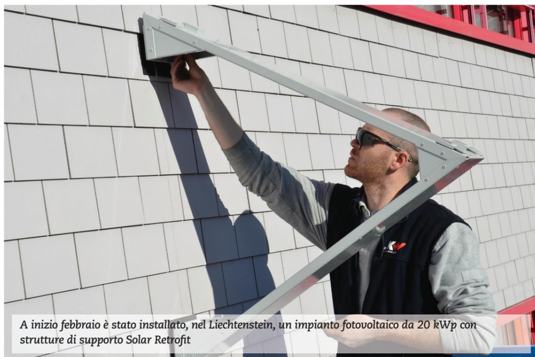
A inizio febbraio è stato installato, nel Liechtenstein, un impianto fotovoltaico da 20 kWp con strutture di supporto Solar Retrofit
