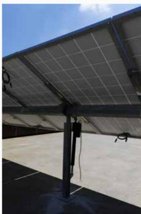
Tracker monoassiali: Progettati con caratteristiche strutturali in grado di ottimizzare l'efficienza dei moduli fotovoltaici. La struttura si presenta robusta, con un giusto equilibrio baricentrico, il che permette di limitare al massimo gli sforzi sul sistema meccanico. Il sistema di gestione e controllo è stato sviluppato in collaborazione con ABB.
