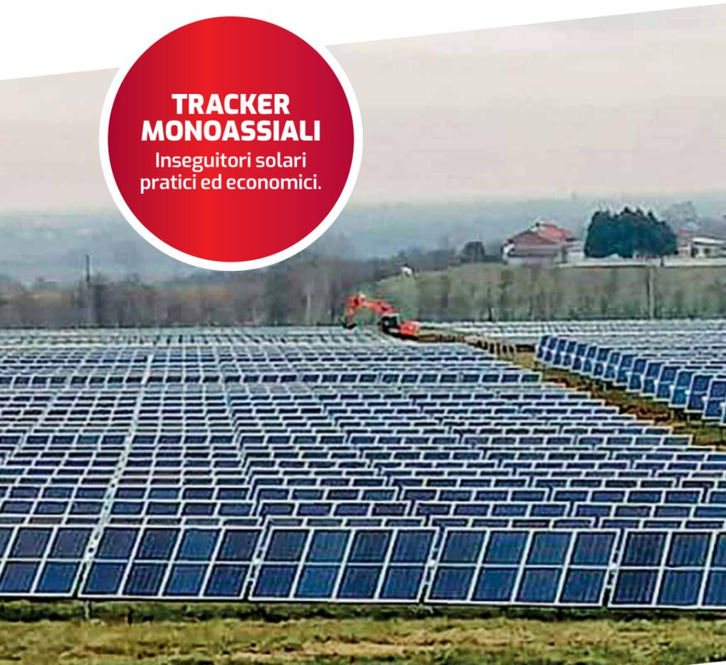
**TRACKER MONOASSIALI:** progettati con caratteristiche strutturali in grado di ottimizzare l'efficienza dei moduli fotovoltaici. La struttura si presenta molto robusta, con un perfetto equilibrio baricentrico il che permette di limitare al massimo gli sforzi sul sistema meccanico. Il sistema di gestione e controllo è stato sviluppato in collaborazione con ABB.
