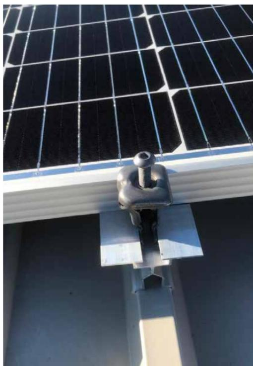
I MODULI SONO STATI ALLACCIATI A PARTICOLARI SISTEMI DI MONTAGGIO A CODA DI RONDINE CHE NON HANNO COMPORATO FORI IN COPERTURA
