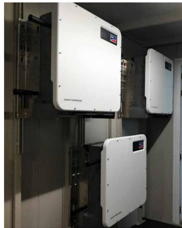
L'INSTALLAZIONE È TRA LE PRIME AD UTILIZZARE INVERTER SMA PEAK 3, SCELTI SOPRATTUTTO PER L'ELEVATA FLESSIBILITÀ DI CONFIGURAZIONE E PER LA PRESENZA DI MENO COMPONENTISTICA, SOPRATTUTTO LEGATA AI CAVI. ANCHE PER QUESTO MOTIVO, L'INSTALLATORE È RIUSCITO A COLLOCARE 12 CONVERTITORI ALL'INTERNO DI UN'APPOSITA CABINA, SODDISFACENDO LE ESIGENZE DEL COMMITTENTE IN TERMINI DI SICUREZZA NELLA GESTIONE E MANUTENZIONE DELLA COPERTURA FOTOVOLTAICA
