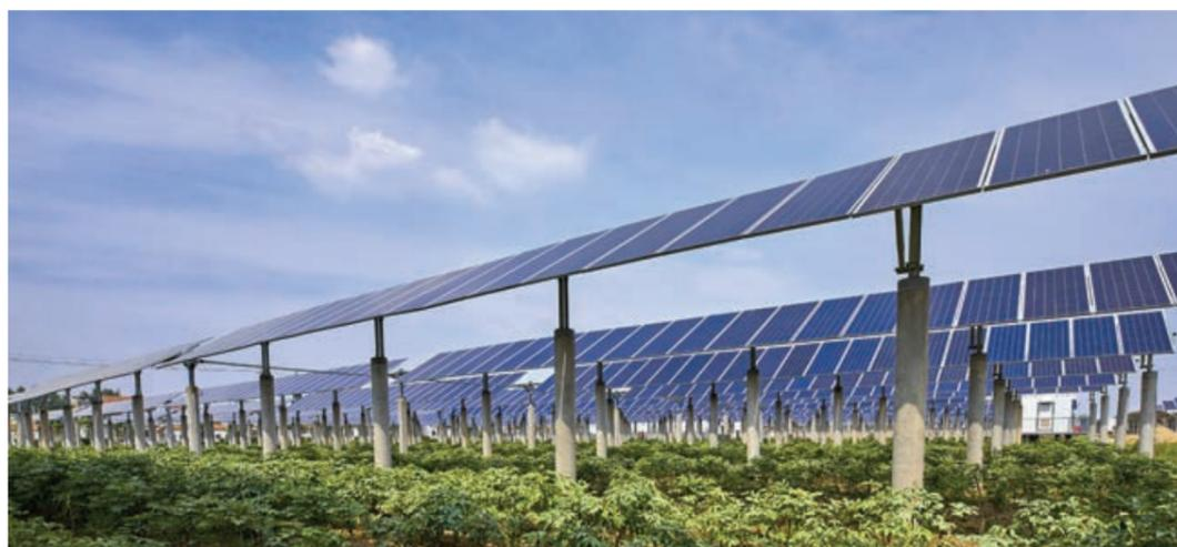
L'AGROVOLTAICO INTEGRA IL FOTOVOLTAICO NELL'ATTIVITÀ AGRICOLA CON INSTALLAZIONI SOLARI CHE PERMETTONO AL TITOLARE DELL'IMPRESA DI PRODURRE ENERGIA E AL CONTEMPO DI CONTINUARE LE COLTURE AGRICOLE O L'ALLEVAMENTO DI ANIMALI. CON L'AGROVOLTAICO, IL SUOLO OCCUPATO DALLE INSTALLAZIONI FOTOVOLTAICHE CESSA DI ESSERE UNA VOCE DI COSTO, ACQUISTO E MANUTENZIONE
