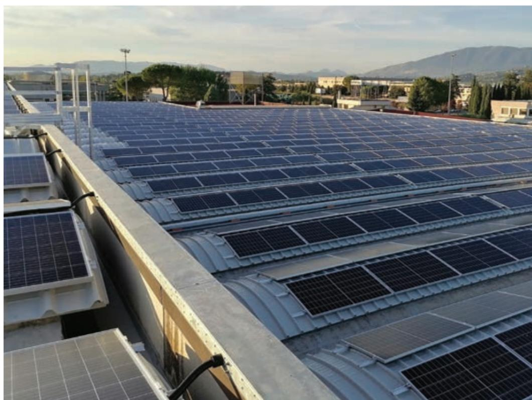
L'IMPIANTO, REALIZZATO SULLE COPERTURE DELL'AZIENDA PLASTICA ALTO SELE, HA UNA POTENZA DI 1 MWP ED È COSTITUITO DA MODULI JINKOSOLAR E INVERTER HUAWEI
