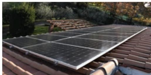
LG HA EFFICIENTATO UNA VILLETTA DI 150 METRI QUADRATI DI VITERBO. GLI INTERVENTI, EFFETTUATI SFRUTTANDO IL SUPERBONUS, HANNO FATTO ARE ALL'IMMOBILE UN TRIPLO SALTO DI CLASSE ENERGETICA. TRA I LAVORI, L'INSTALLAZIONE SUL TETTO DI 15 MODULI LG NEON 2 BIFACIAL CON POTENZA FINO A 400 WP
