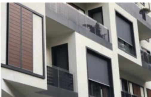
Energyglass, divisione della società GruppoSTG specializzata in soluzioni fotovoltaiche integrate architettonicamente, ha realizzato, in collaborazione con l'azienda Faraone, "Balcone Fotovoltaico", un parapetto fotovoltaico BiPV.
