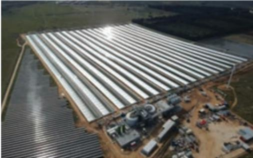
A Partanna, in provincia di Trapani, è entrato in funzione un parco fotovoltaico da 5,4 MWp, a cui è affiancato anche un impianto termodinamico. Meteocontrol ha fornito il proprio sistema di monitoraggio per il controllo dei tre inverter centralizzati SMA, oltre a un monitoraggio di zona per il controllo della corrente di stringa, sensoristica in campo e il Power Plant Controller (PPC) che permette all'impianto di ottimizzare l'immissione in rete di energia.
